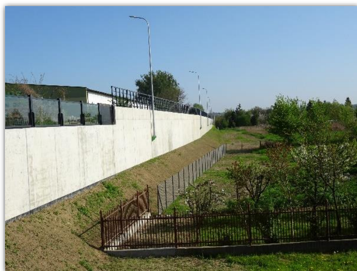
Mur oporowy wzdłuż ul. Mostowej
